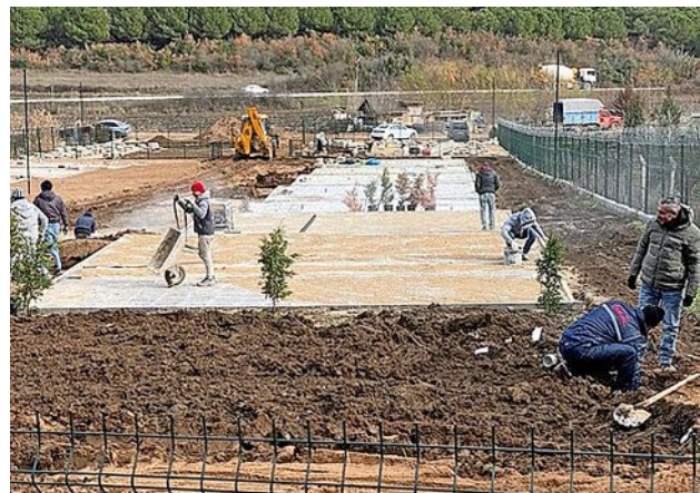
Der Bau des neuen Tierheims kann nun weitergehen. PRIVAT
